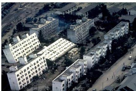
**Debido a la licuefacción del suelo sobre el que se sustentaban, éstos edificios han volcado hundiéndose parcialmente.**
