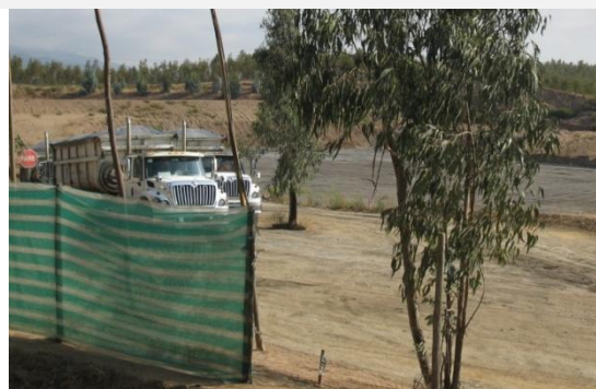
B) Relleno industrial AES GENER ubicado dentro de polígono, a continuación de vertedero municipal de Puchuncaví.
